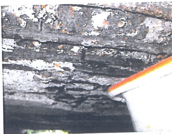
Figuur 3.4: Verdeelwapening geheel omgezet in corrosieproducten
